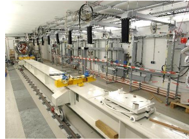
Cryomodule test stand
