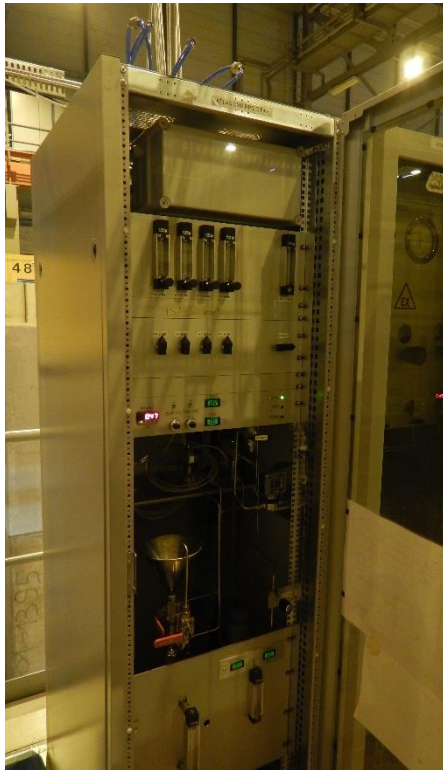
Gas recirculation module
