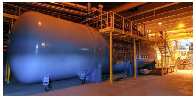
Cold box του 18 kW refrigerator @ 4.5 K
