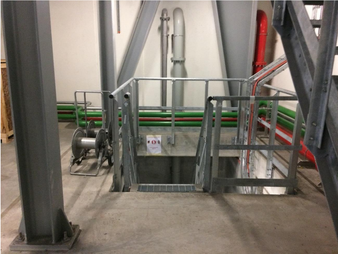
Accès galerie GNH106
