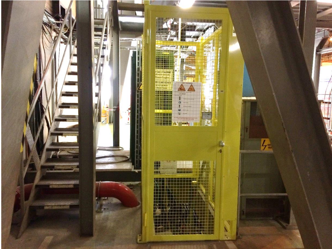
Accès galeries EHN1 existant (à terminer)
