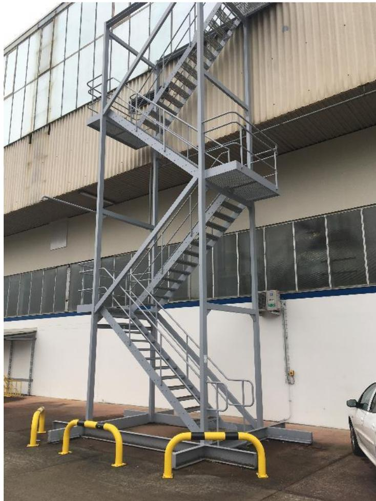
**Figure 10** : Exemple d'escalier d'accès en toiture
