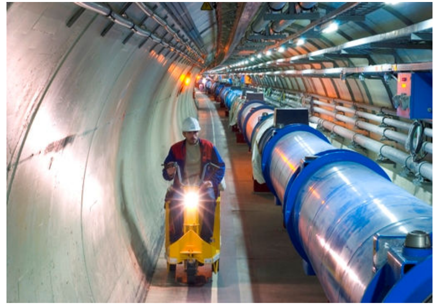
Túnel do LHC
