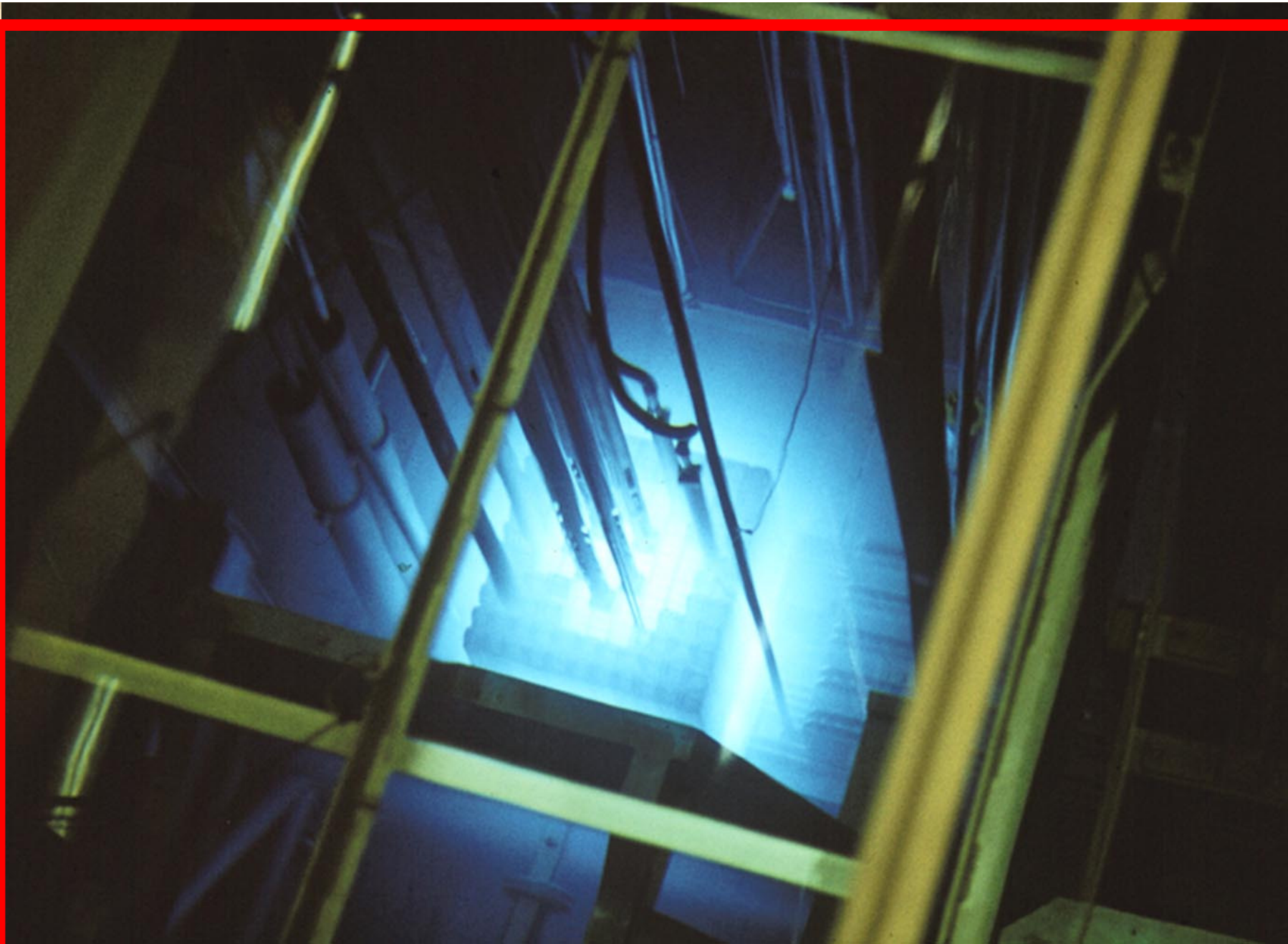
10 MW swimming pool reactor, Geesthacht (D)
