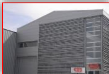
Polígono Ugaldeguren III Zamudio (Bilbao)
