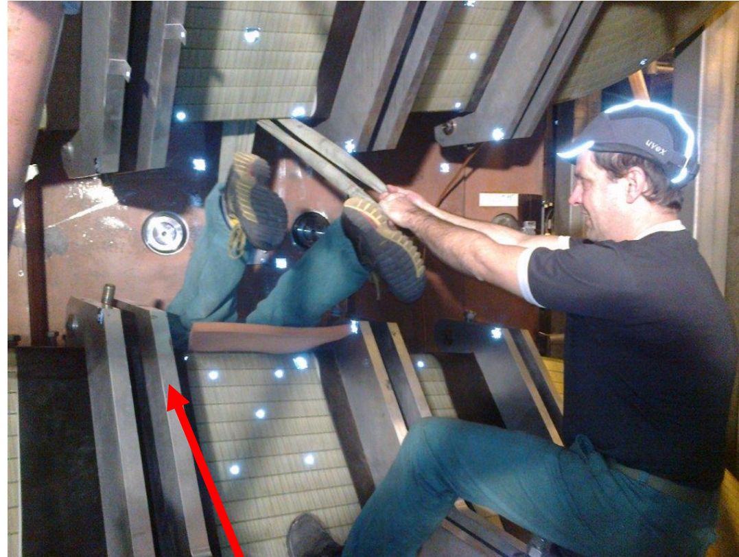
Démontage des clamps et sortir les anciens caoutchoucs
