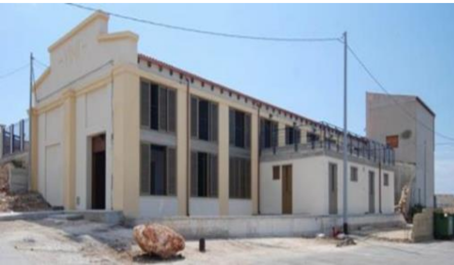
ARCA shore station @ Portopalo di Capo Passero
