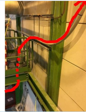
Passage des fibres avant de rejoindre le chemin de câbles vertical vers fenêtre 1.
