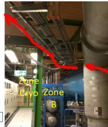
L'entrée des fibres dans la zone Cryo. EN-EA à vérifier
