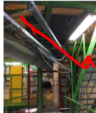
Passage des fibres avant de rejoindre le chemin de câbles vertical vers fenêtre 1.
