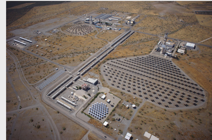
Almería Solar Platform (PSA)
