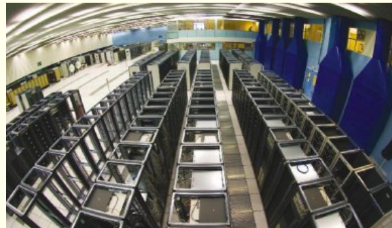
Hala w CERN przygotowana do montażu PC w szafach RACK
