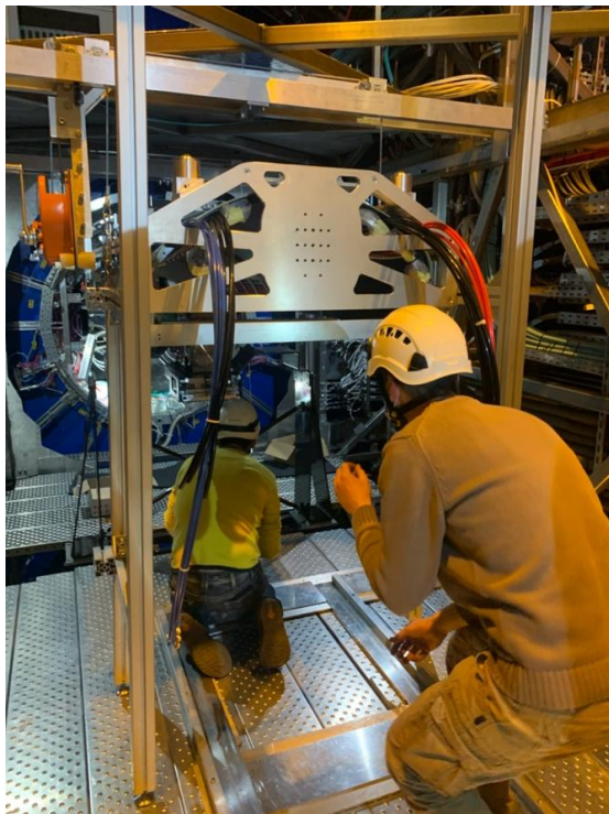
H1 installation (Tue)
