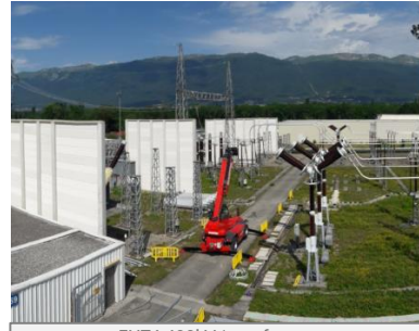
EHT4 400kV transformer
