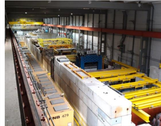
EHN2 new crane
