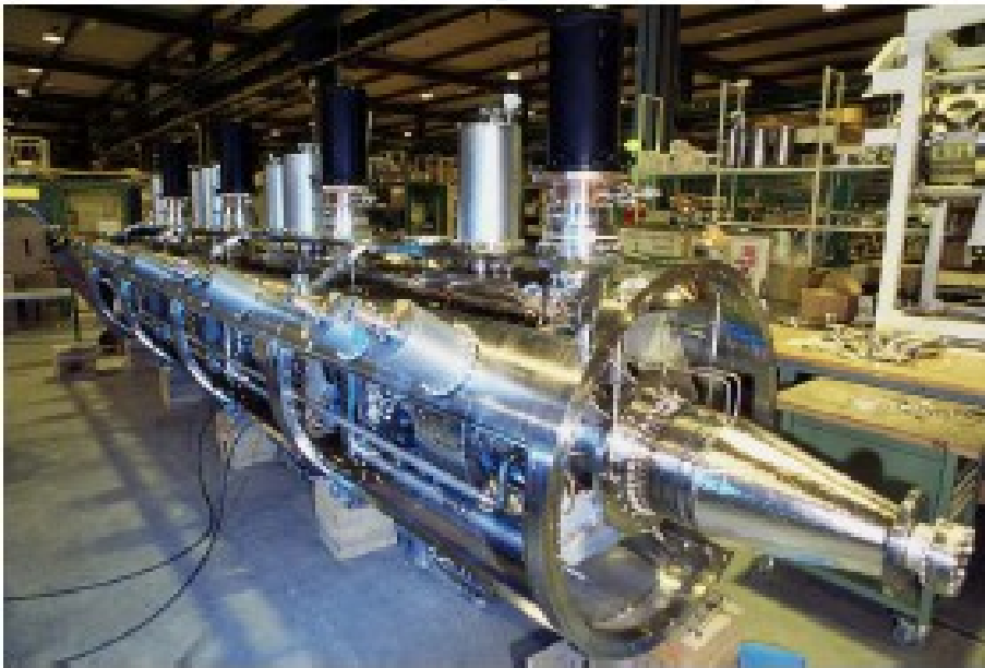
Módulo de una cavidad de RF del LHC
